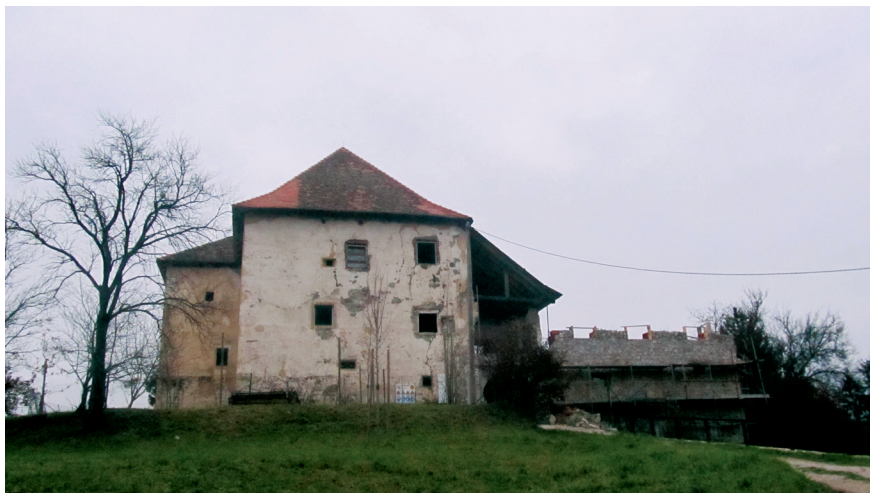
Fotografija 26: Prenovitvena dela na Gradiču leta 2012. Fotografije na terenu, 2012.
