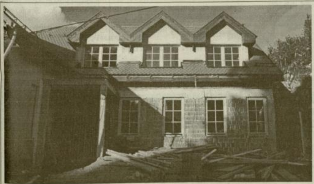
Gradbena dela v šoli na Paškem Kozjaku so tik pred zaključkom.
