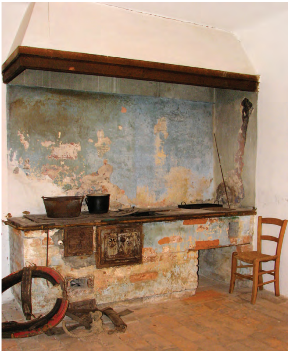
Židan štedilnik z litoželezno ploščo, pečico (fornom), gonišem, fornolom in napo v Muzeju furlanske kmečke kulture v Fari / Museo della Civiltà Contadina Friulana, Fara D'Isonzo. (Foto: Špela Ledinek Lozej, 2009)
