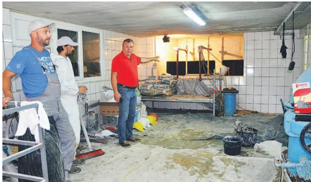
Primož Rošer nam pokaže, kje je vodna celica, ki jo obnavljajo. Najstarejša in najbolj dotrajana celica za skladiščenje pitne vode je globoka 5 metrov, a dna ne vidimo. Delavci namreč sedaj obnavljajo strop v njej.
