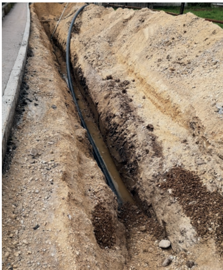
Obnova vodovoda na Čolnarski ulici na Igu
