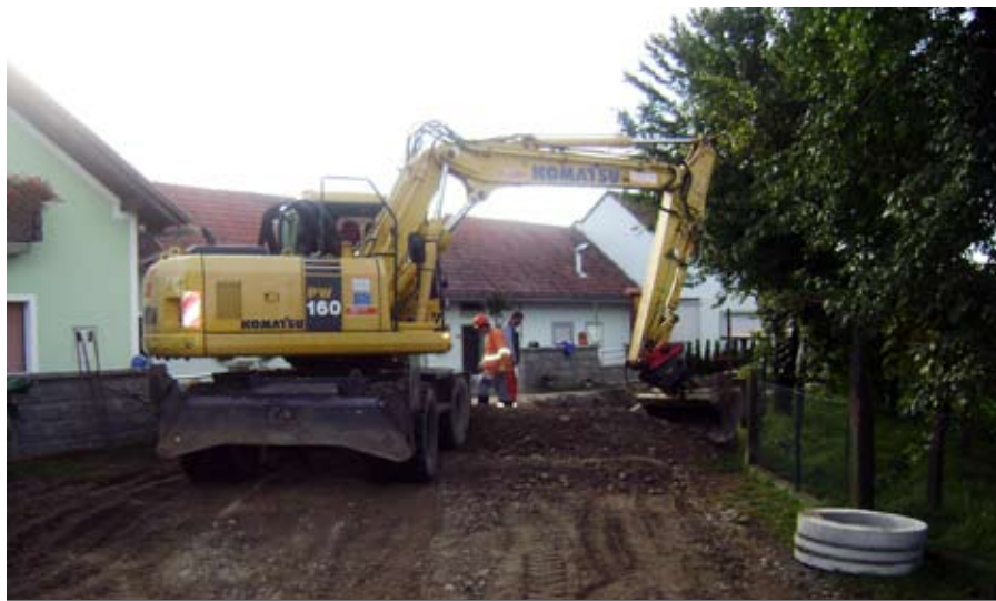
Izgradnja kanalizacije v naselju Stojnci Foto: Občinska uprava
