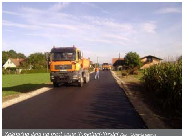
Zaključna dela na trasi ceste Sobotinci–Strelci Foto: Občinska uprava
