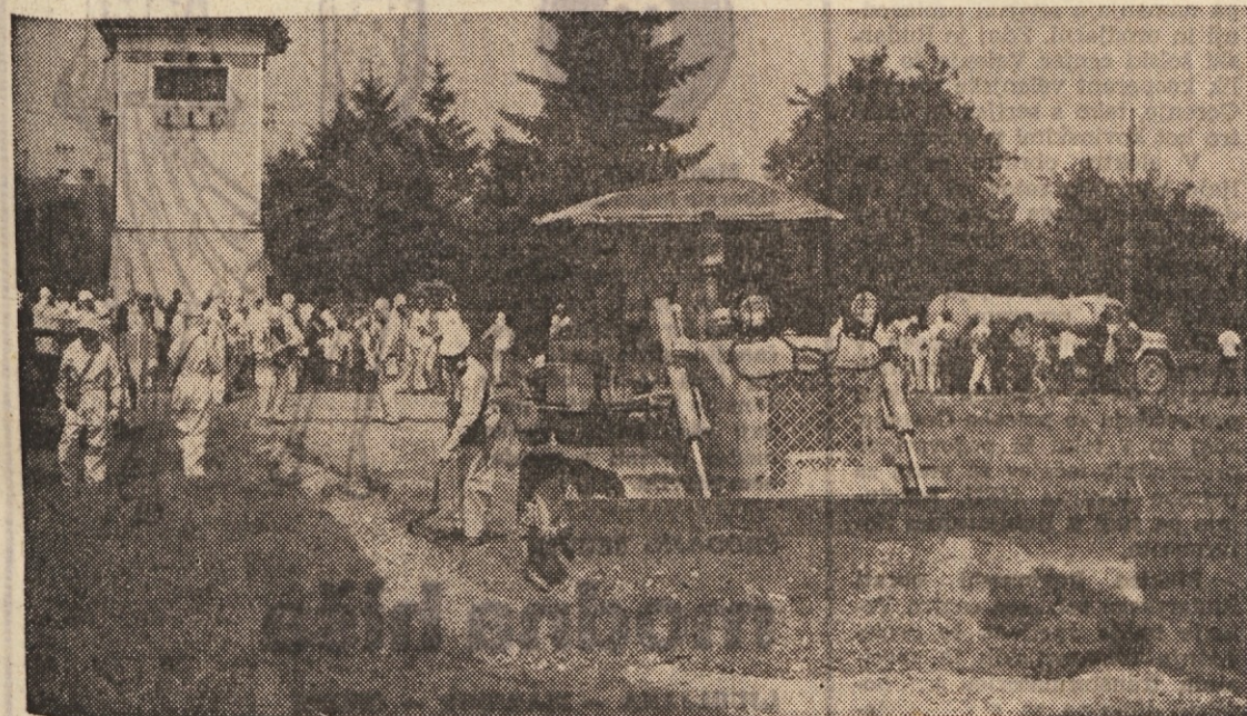
Buldožer odstranjuje zgornjo — zastrupljeno plast cestišča
