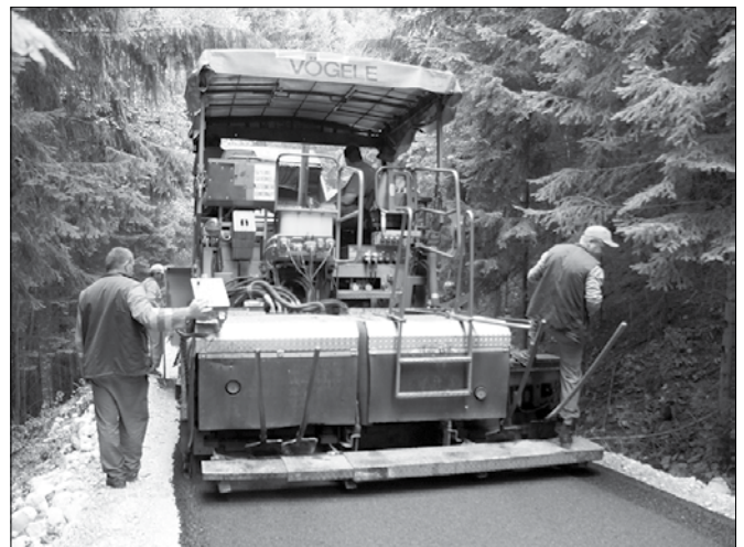
Asfaltiranje ceste na odseku Robnik-Mlačnik (Foto: Marija Lebar)
