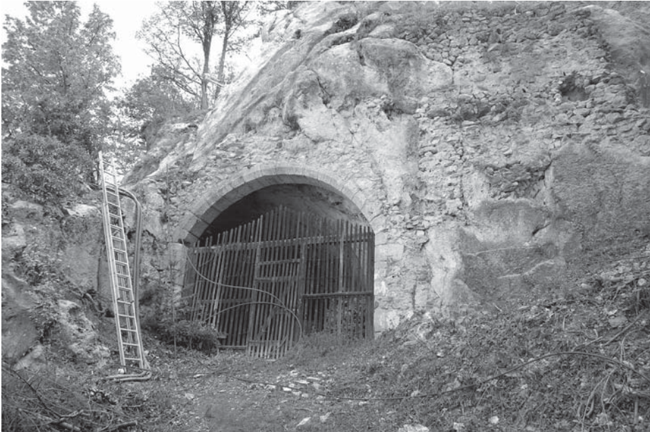
Bild 6: Das Portal der Höhle mit spätgotischen Einfassung. Links davon das Widerlager des romanischen Annexes. Rechts das Widerlager der spätgotischen Pfarrkirche.
