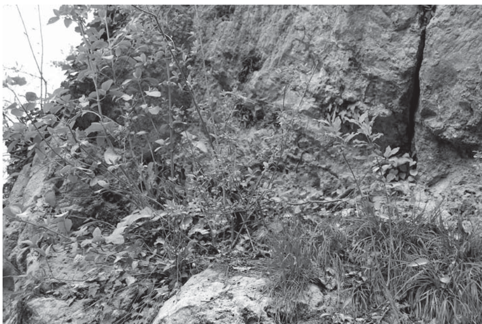
Bild 14: Widerlager für den Anbau außerhalb des Portals.
