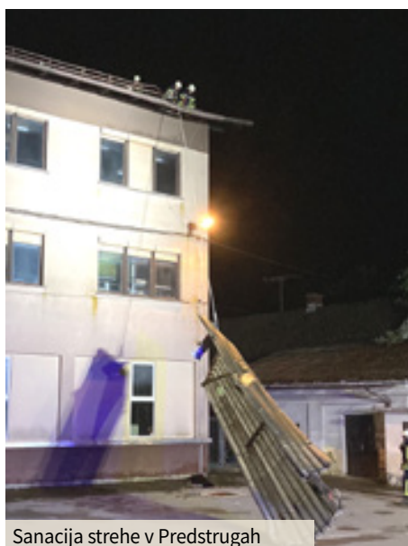
Sanacija strehe v Predstrugah
