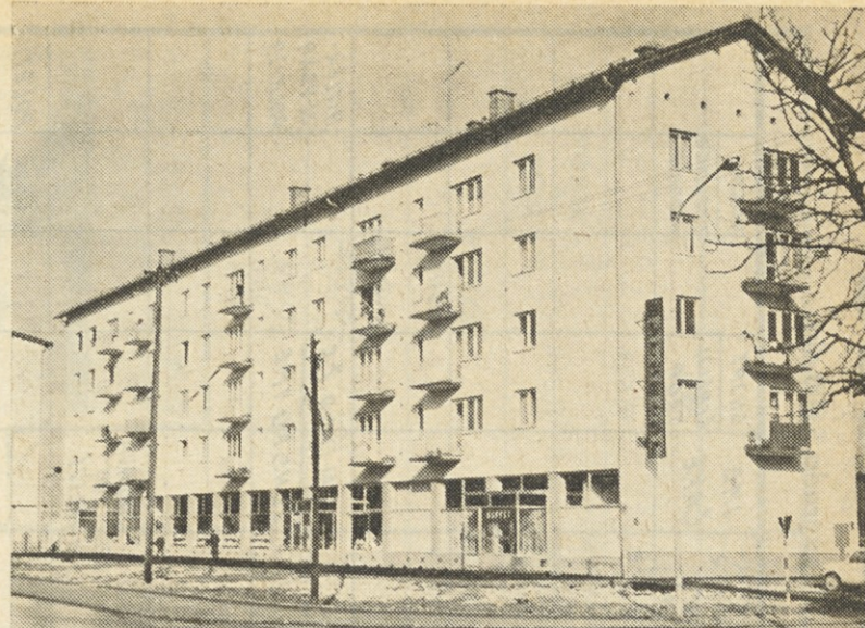
Zunanje pročelje odprte samopostrežne prodajalne v Pokopališki ulici
