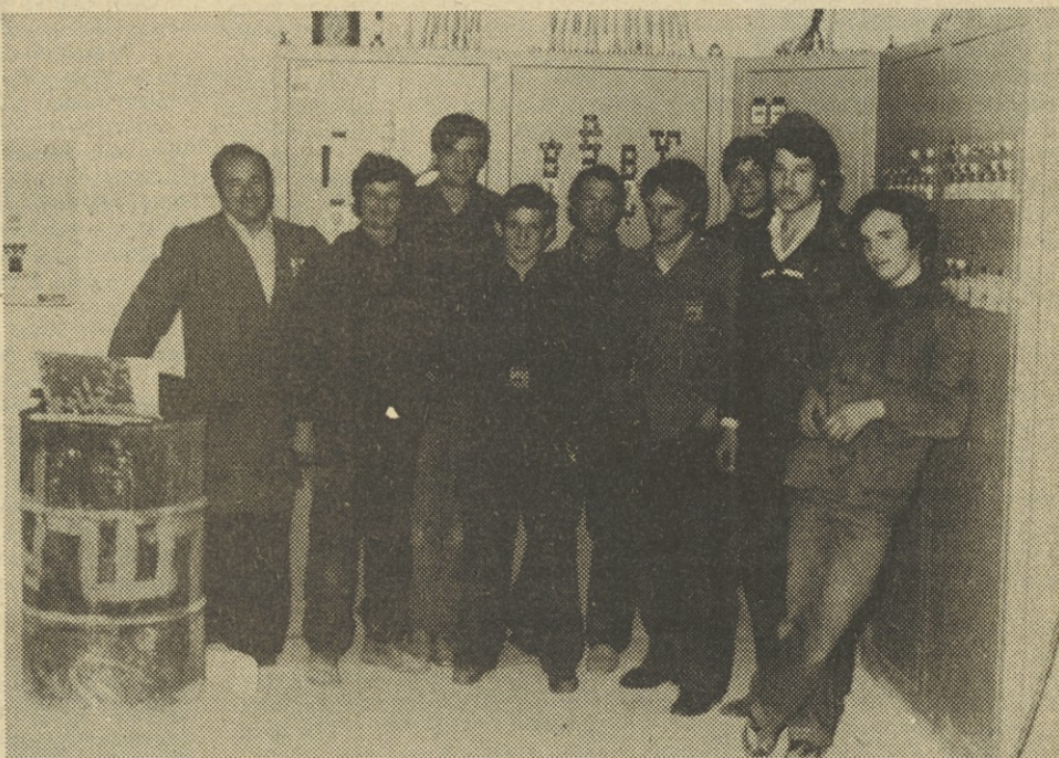
Ekipa monterjev TOZD Elektromontaža na gradbišču Iskrine Elektrooptike
