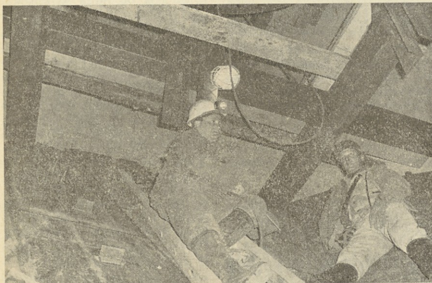
Jože Majcen in Roman Sloka sodelujeta pri montaži presipnega bunkerja nad vpadnikom zvezno — 7. obzorje v jami Hrastnik. (Foto A. Bregant)
