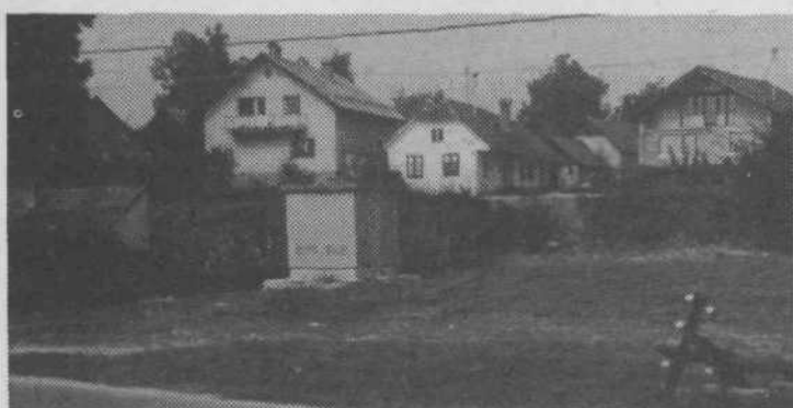
Eden novih transformatorjev v starem predelu Zaloga, ki je rešil problem nizke napetosti. V neposredni bližini bo zrastle prvi park, ki ga bodo mladinci in drugi Založani uredili s prostovoljnim delom.
