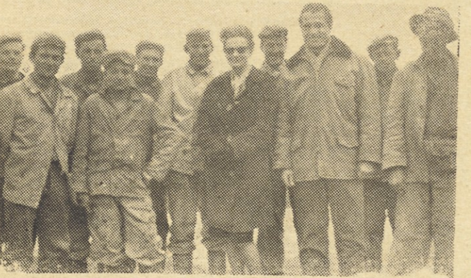
Del članov kolektiva, ki gradi v Mariboru najmodernejši gasilski dom
