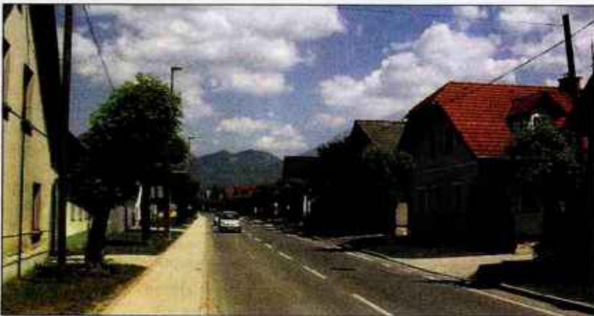
Kanalizacija je zgrajena že v skoraj celotnem Šenčurju.
