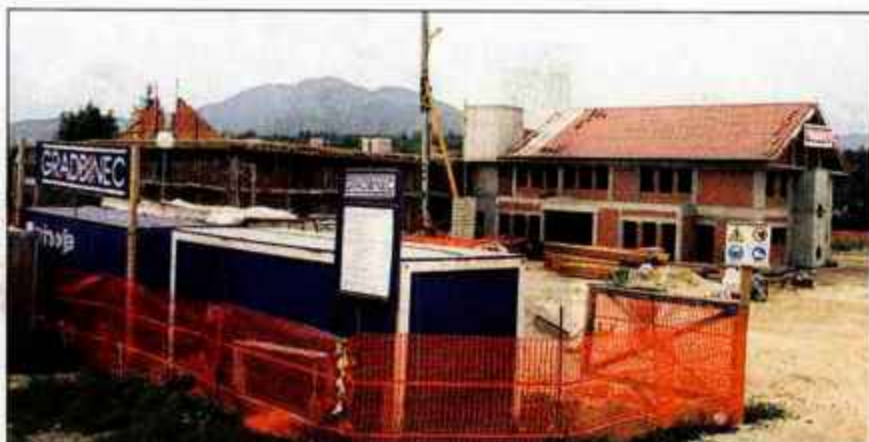
Gradbinec GIP se želi vključiti v gradnjo doma starejših občanov v Naklem tudi kot soinvestitor, Občina Naklo pa bo najela posojilo za gradnjo prve etape.
