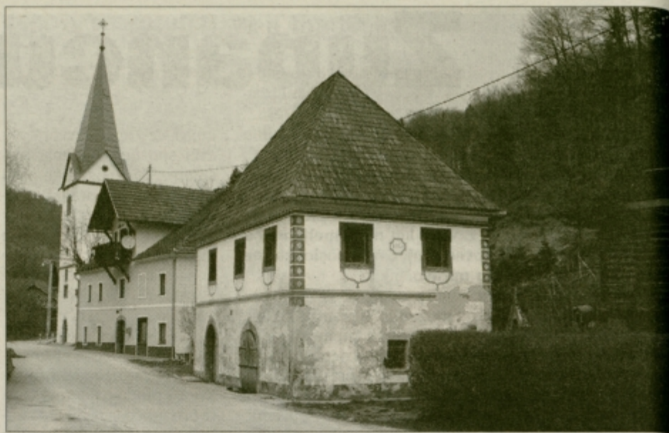
Rotovž v Lembergu pri Šmarju je že dolgo prazen. Zato je po približno dveh desetletjih spet potreben obnove.
