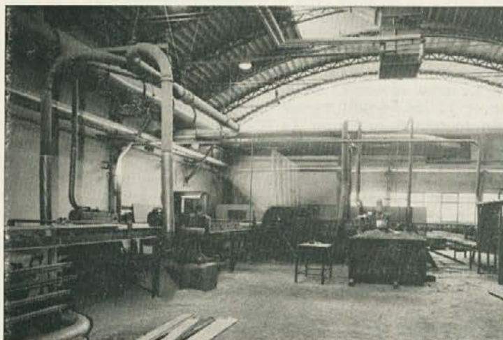
Notranjost proizvodnih prostorov
