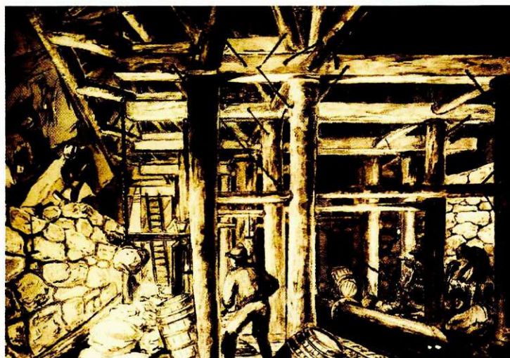
Graditev opornega zidovja
