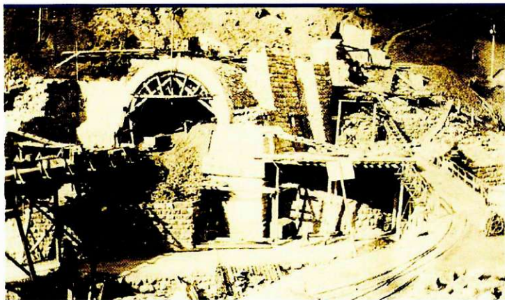
Gradbišče v Podbrdu
