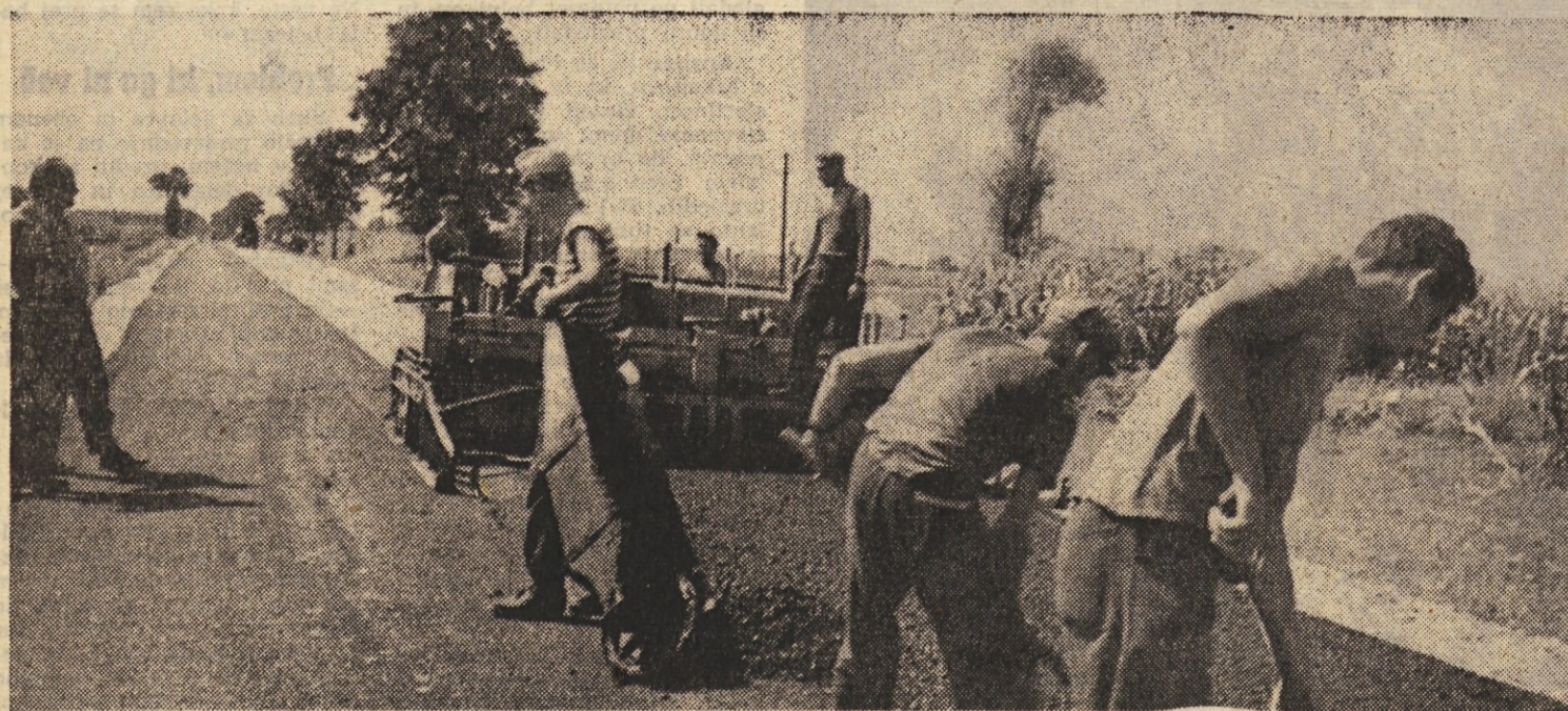
Slabe ceste v Prekmurju so odvrnile marsikatero turist, da bi si ogledali ta lepi predel slovenske zemlje. Če se pelješ danes iz Maribora proti Murški Soboti, boš lahko ugotovil, da voziš po eni izmed najlepših cest v Sloveniji — asfalt je prekril prašno podlago. Z modernizacijo cestišč še nadaljujejo. Prav te dni finišerji polagajo asfalt na cesti Murška Soba—Rakičani
