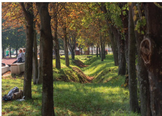
Zadrževalniki padavinske vode. Foto: Matej Čagala, Lukáš Patrik
