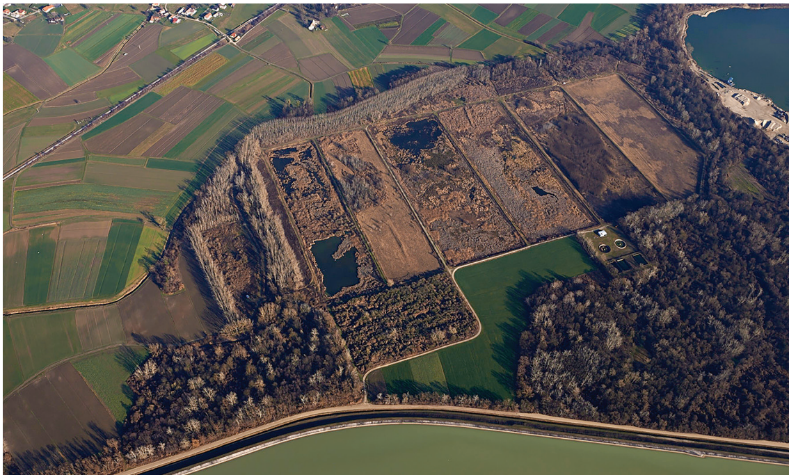
Pogled na območje bazenov odpadnih vod Tovarne sladkorja Ormož pred obnovo. Foto: Arhiv DOPPS
