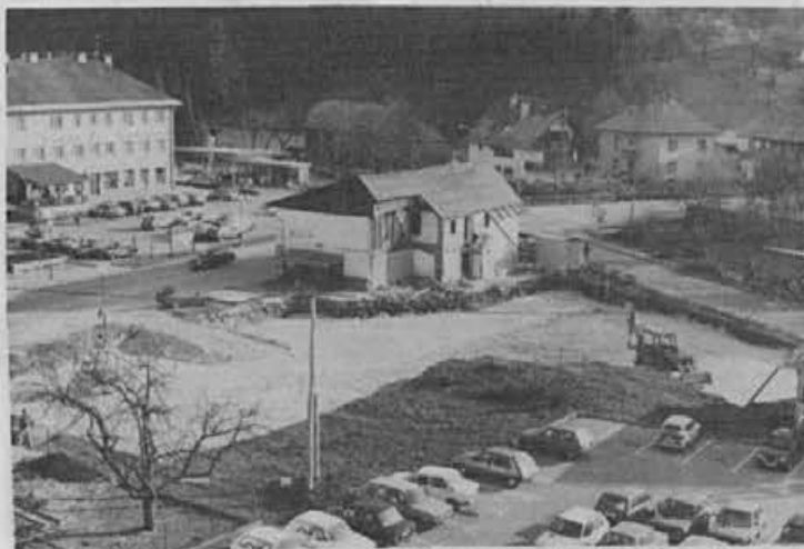
Gradnja poslovno-stanovanjskega centra Pri Matic se je začela
