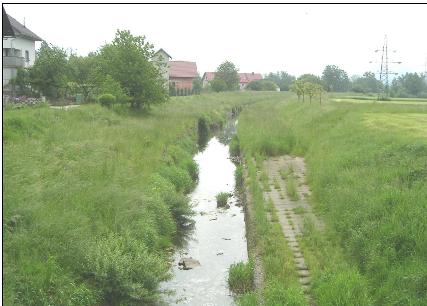
Avtorska slika 6: Razbremenilni kanal visokih deževnih vod – Preserje pri Domžalah
