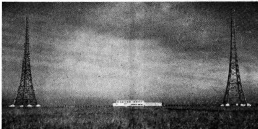
● Oddajnik radijske postaje v Münchenu (antena in stavba s stroji, aparati)
