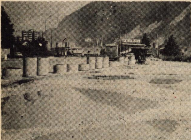
Jesenice — Te dni so na prometnem križišču na Plavžu uredili tudi avtobusno postajališče. Zasadili bodo še okrasno grmičevje in rože, tako da bo izgled lepši. — Foto: J. Zerdin
