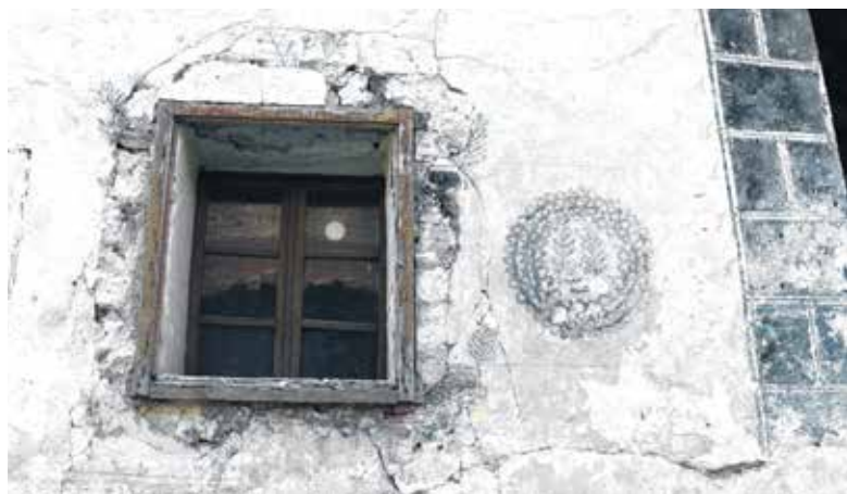
Vzhodna fasada hiše z bogato okrašenjo okensko odprtino, poslikavo v rozeti in šivanim robom (foto: M. Pergar)
