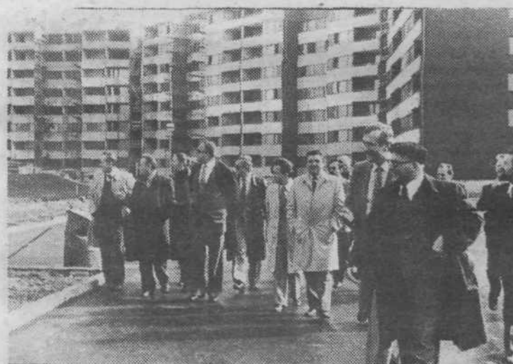
Predsednik CK ZKS France Popit si je 14. oktobra ogledal gradnjo nove stanovanjske soseske na Fužinah. Ob tej priložnosti je s predstavniki naše občine pogovarjal o težavah pri graditvi te soseske in o razmerah v gradbeništvu nasploh. Pogovora sta se udeležila tudi predsednik mestne konference ZKS Marjan Orožen in predsednik ljubljanske mestne skupščine Marjan Rožič (Foto: D. J.)
