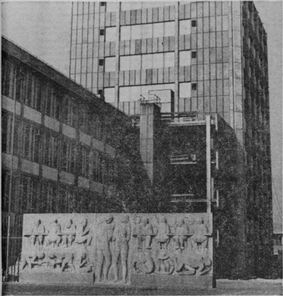
Pri izgradnji poslovno-proizvodne zgradbe celjskih Zlatarn je sodeloval Razvojni center s celovito ponudbo inženiringa.
