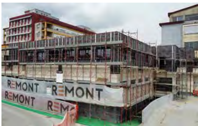
>> Gradnja novih prostorov za dializo v Splošni bolnišnici Murska Sobota.
