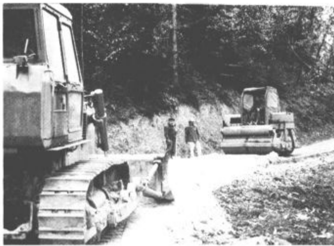
Vreme jim pri posodobitvi ceste pošteno nagaja. Kljub temu naj bi dela končali do 15. novembra letos
