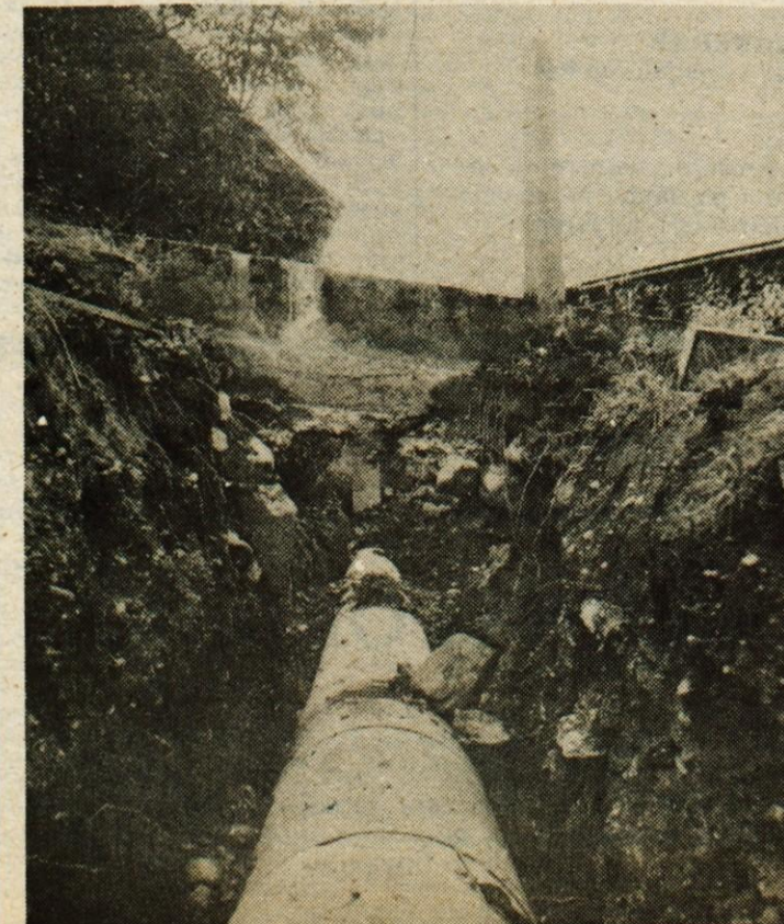
Pri izgradnji kanalizacije so krajanje naredili že prek 1000 prostovoljnih delovnih ur. Iz vsake hiše na Bregu ob Kokri se bodo priključili na javno kanalizacijo.
