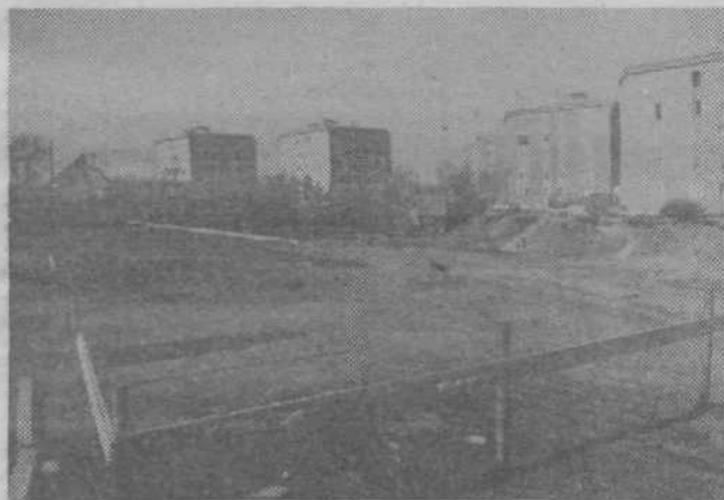
Splošno gradbeno podjetje Grosuplje je konec preteklega leta pričelo s pripravami za gradnjo nove samopostrežne trgovine v Polju. Zdaj sicer šele kopljejo
