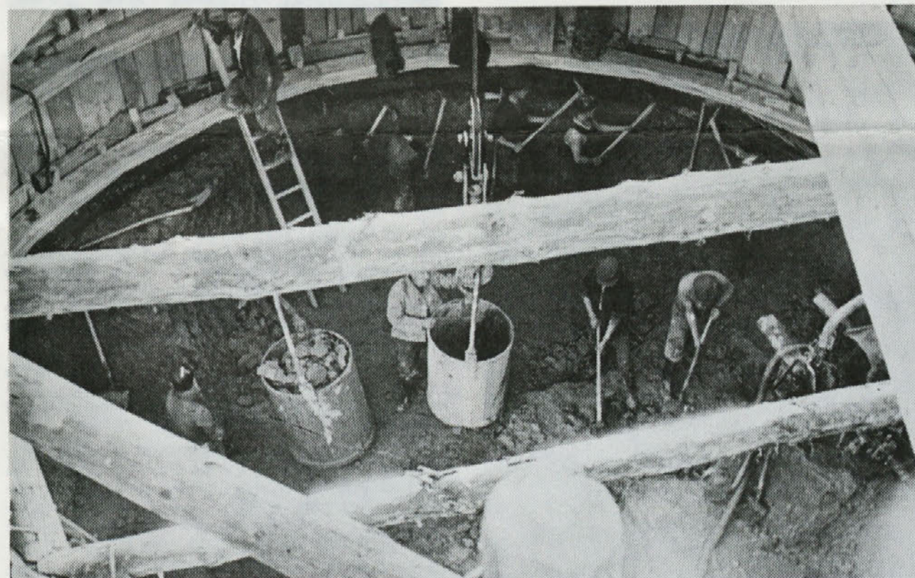
In potem so proti koncu štiridesetih let začeli graditi izvažalni jašek v Prelogah in iz jame Škale "gnati" proti njemu zvezne vpadnike
