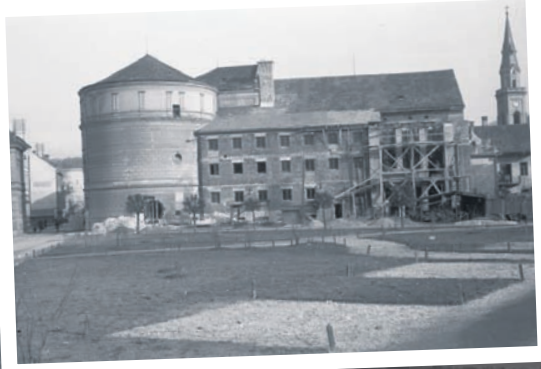
Gradnja prizidka Mestnega gledališča Celje pred letom 1952 (Zgodovinski arhiv Celje, SI_ZAC/1028/005_00283, Fototeka Božič Milan)
