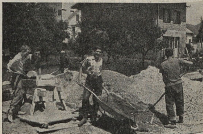
Na gradbišču stolpičev v Ribnici preživljajo svoje počitnice nekateri ribniški šolarji. Mnogo je žuljev, a denar je tudi lepo prešteti ob koncu meseca... Foto D. Mohar
