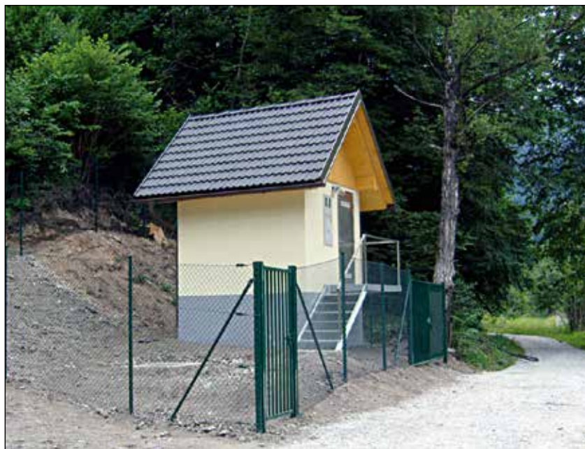
Novozgrajeni vodovod na Jesenovcu.
