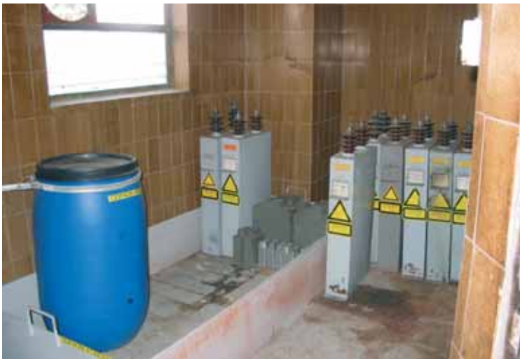
Kondenzatorji z novimi mineralnimi organskimi olji
