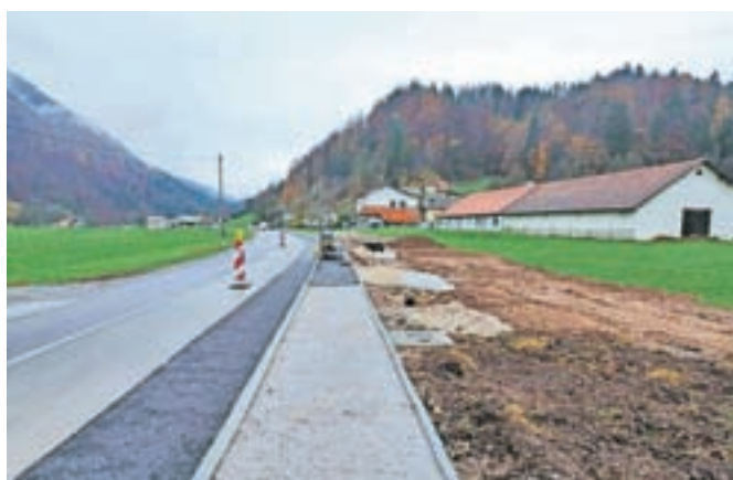
V Srednji vasi so hkrati zgradili še pločnik. / FOTO: OBČINA KAMNIK
