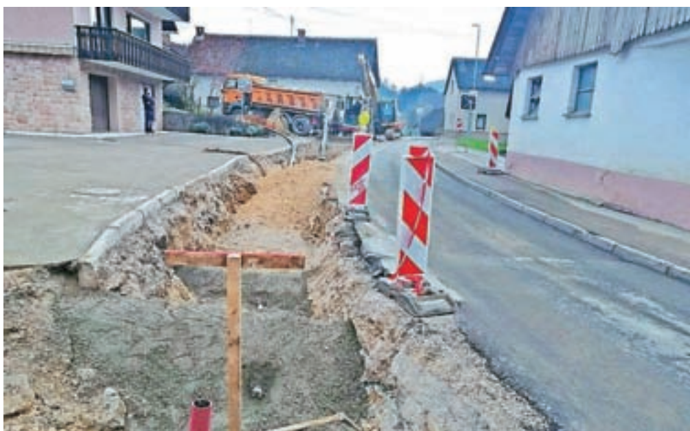
Gradnja kanalizacije v Buču / FOTO: OBČINA KAMNIK
