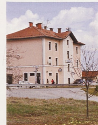
Z nadvozom se bo uredil tudi podhod pod železniško progo.
