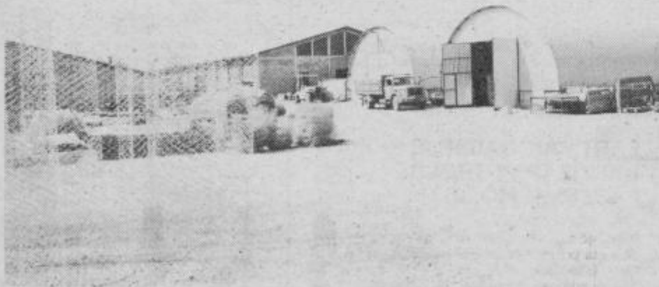
Priprava žičnih kosar za zavarovanje nabrežin
