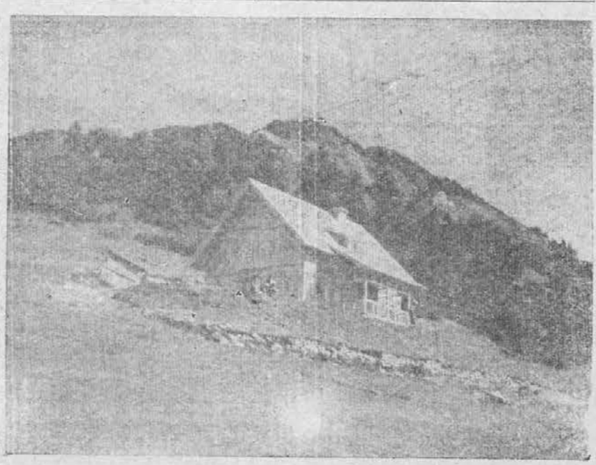
Novozgrajeni Robljakov dom na Begunjski
