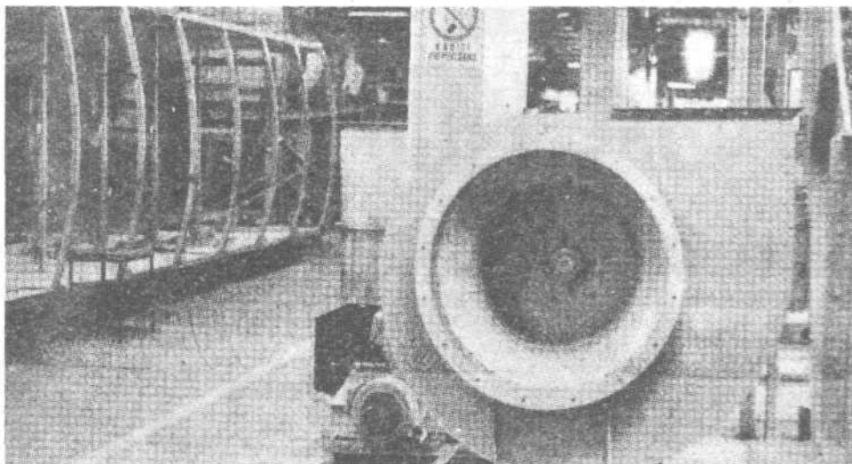
Del linije za toplotno obdelavo tobaka ob montaži
