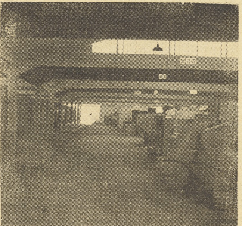
Pogled v notranjost skladiščne hale
