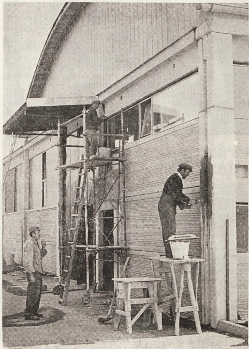
Zaključna dela pri novi proizvodni hali za tapetništvo
