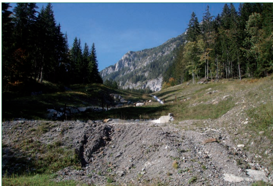
Macesnikov slap po sanaciji. Foto: Primož Pipan.
