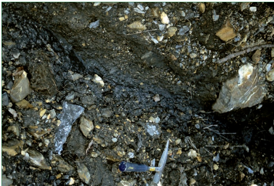
Skrilavi glinovec v Macesnikovem plazu. Zaradi zasičenosti z vodo in rahlosti gradiva prihaja do utekočinjenja ali likvefakcije.
