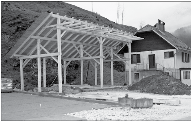
Lesena konstrukcija cestnega silosa bo dobila še stene.
