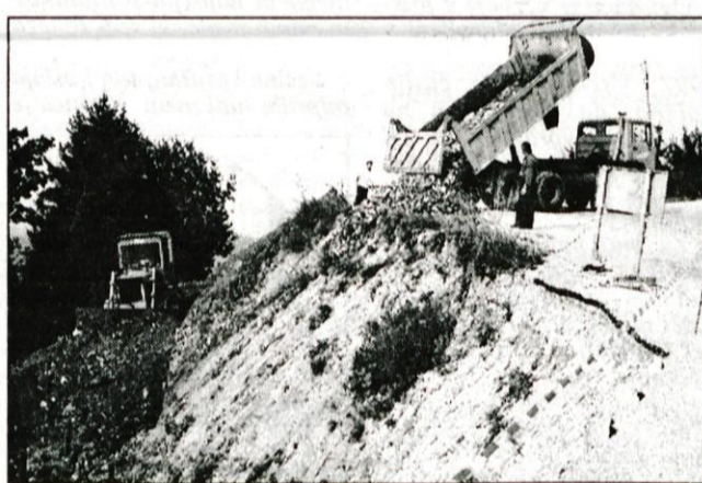
Popravila ceste v Leše sta se lotila podjetnika iz sosednjih Palovič.
