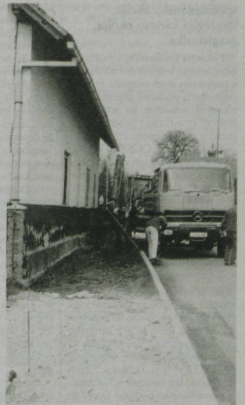
Še iz leta 1996 je ostala nedokončana Koliška cesta, ki je zaradi svoje prometne obremenjenosti na eni in neurejenosti na drugi strani povzročala veliko slabe volje med vozniki pa tudi domačijami ob njej. Še malo, pa bo neurejena cesta le še zgodovina.
