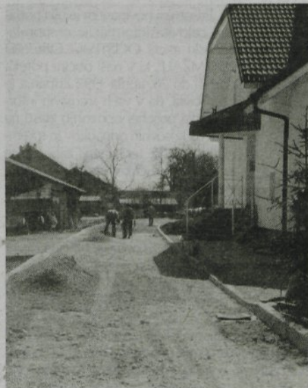
Na vrsto je prišla tudi Ručigajeva ulica v krajevni skupnosti Jarše-Rodica, kjer je bilo potrebno pred asfaltiranjem ulice položiti tudi kanalizacijo. Modernizirani odsek je dolg 200 m.
