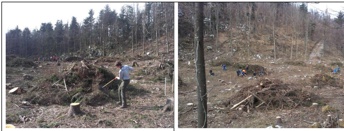
Slika 34: Priprava tal na objektu Postojna / Javorniki
