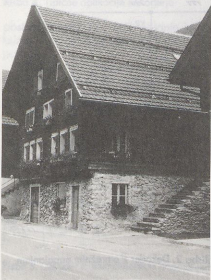
V osrednjem delu Švice so hiše spodaj kamnite, zgoraj pa lesene. Vhod v zgornji del je po zunanjih stopnicah, podobno kot pri bovški hiši.
